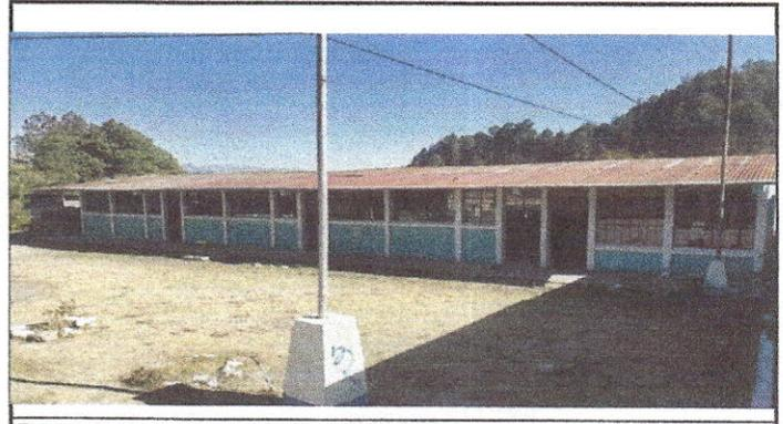
Foto 2: En la se observa la lámina del techo que será sustituido por lámina troquelada aluzinc calibre 26 que será de 306.99 mts cuadrados
