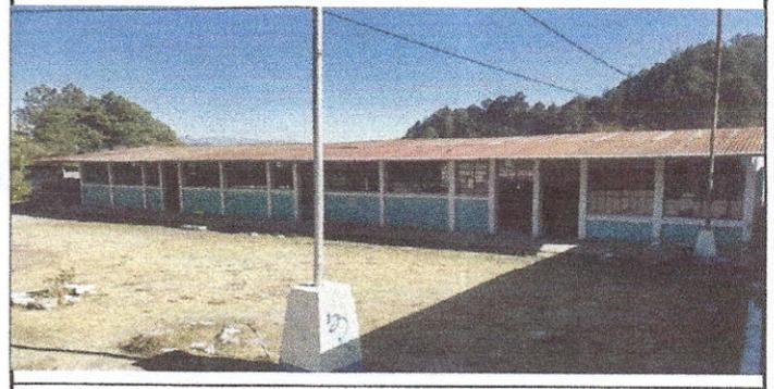
Foto 2: En la se observa la lámina del techo que será sustituido por lámina troquelada aluzinc calibre 26 que será de 306.99 mts cuadrados
